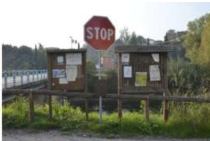
Ponte strada provinciale
