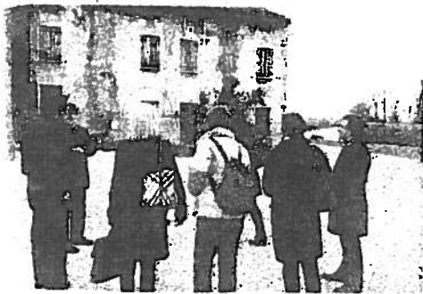
Rivalta edificio da includere - Al vaglio la possibilità di messa in sicurezza dell'edificio
